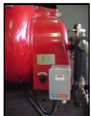
Autoflame air servo.
